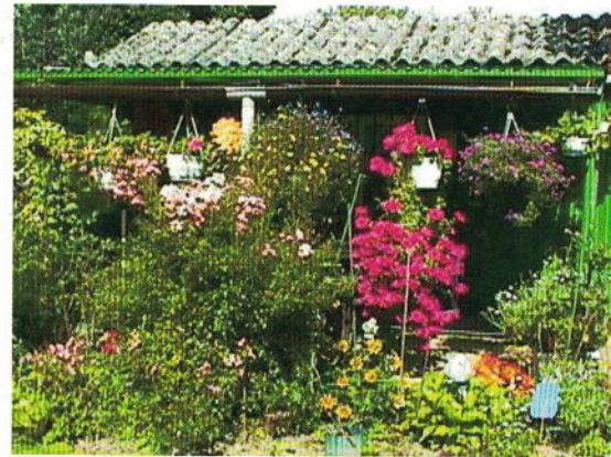
Diese Laubentypen mit Asbestzementdach sind in Düsseldorf noch vielfach zu finden. Foto: Claas
