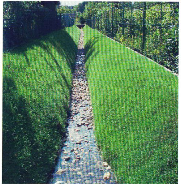
Der Wassergraben nach der Sanierung
